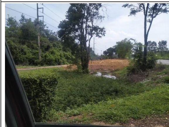
มีการถมดินปิดปากท่อม
